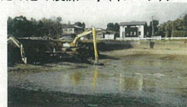
＜ため池の浚渫工事（イメージ）＞
