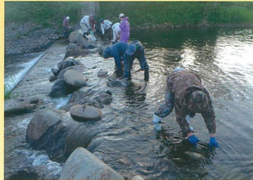
農業用水確保のための樋門前の石堰の設置作業 鳥取県琴浦町(出上農地・水保全活動組織)
