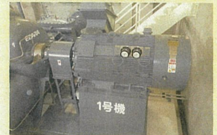
高効率電動機への更新
