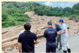
被災地で流木の状況を調査
