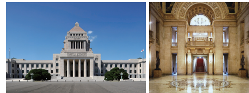
1階は徳山石、2階以上は尾立石 中央玄関広間と中央階段
