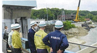
5/21 明治用水頭首工で発生した漏水事故に関し復旧作業の状況を視察
