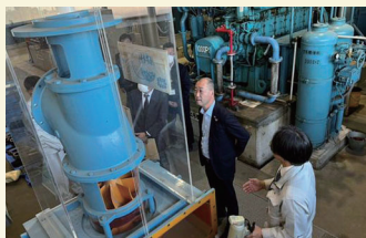
10/13 宮城県下の排水機場を視察
