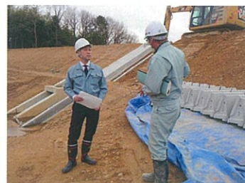
ため池工事の現場を調査
